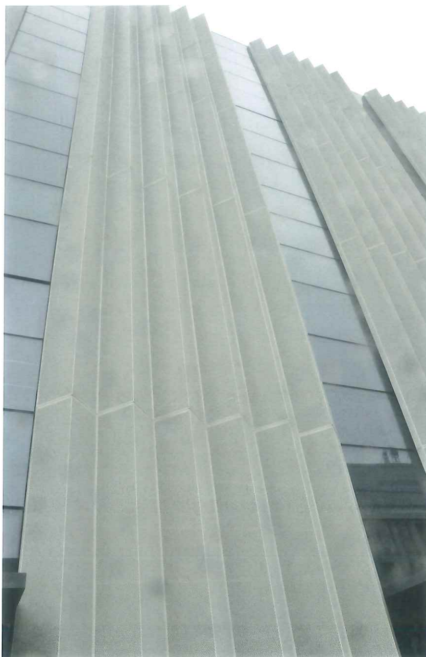
室外玻璃、穿孔铝板等多种材料组合幕墙
