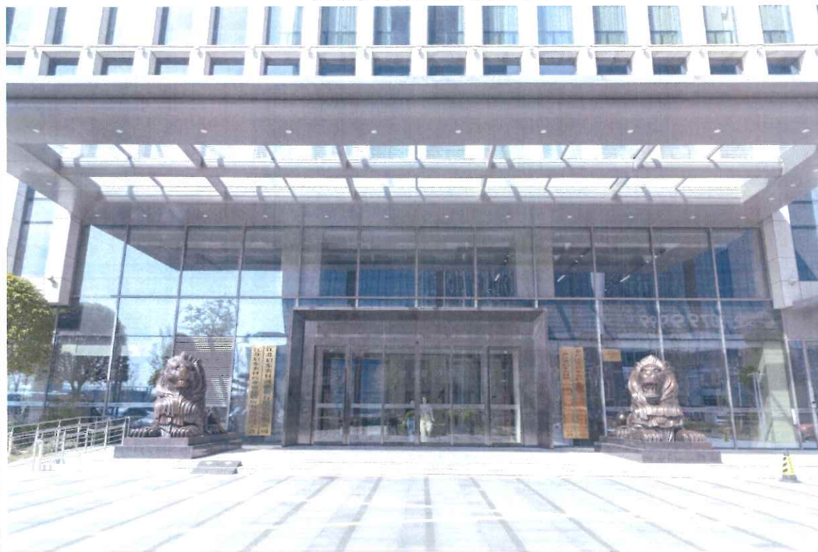
启东农商行大厦大门正立面
