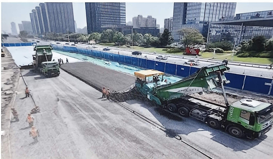
水泥稳定碎石摊铺
