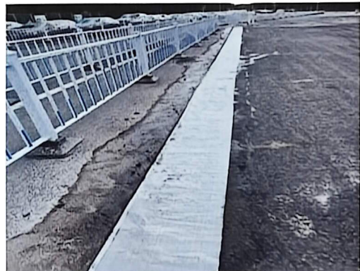
接缝铺贴抗裂贴
