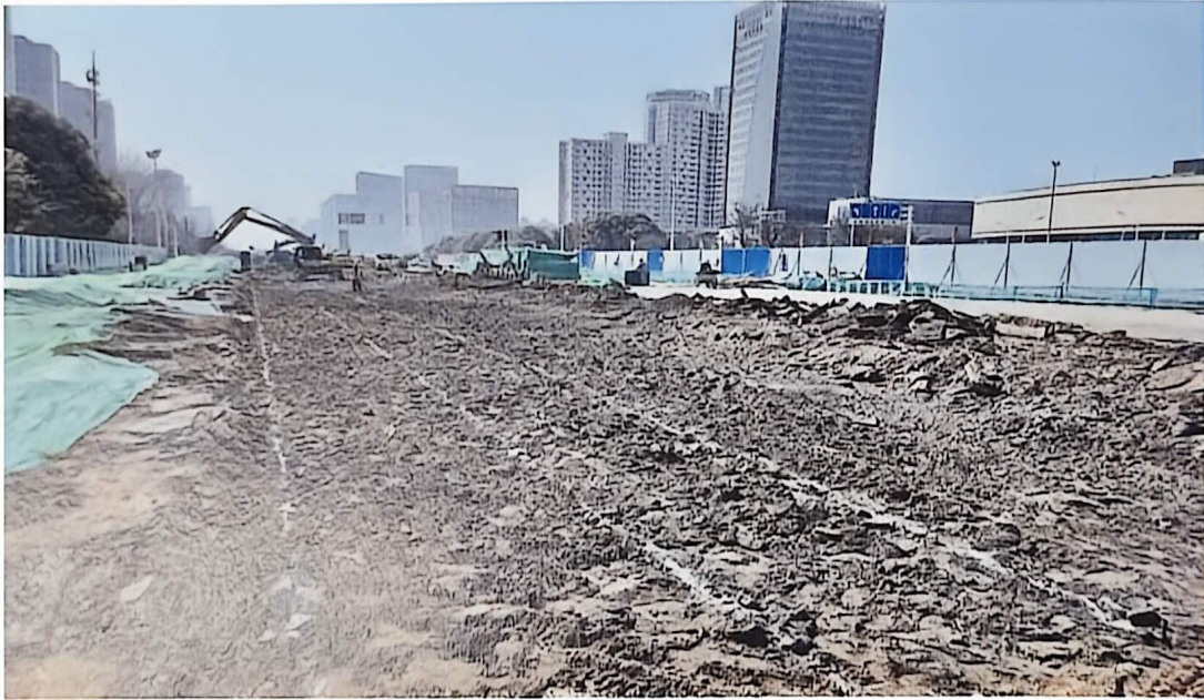
雨水管道放线
