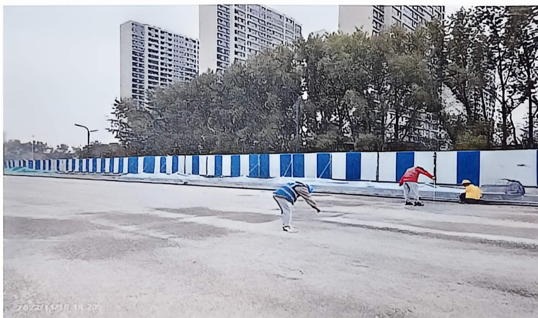
水泥稳定碎石顶面验收
