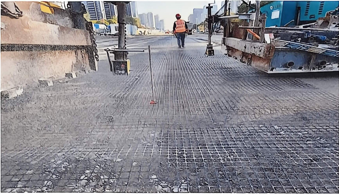
防裂土工格栅铺贴
