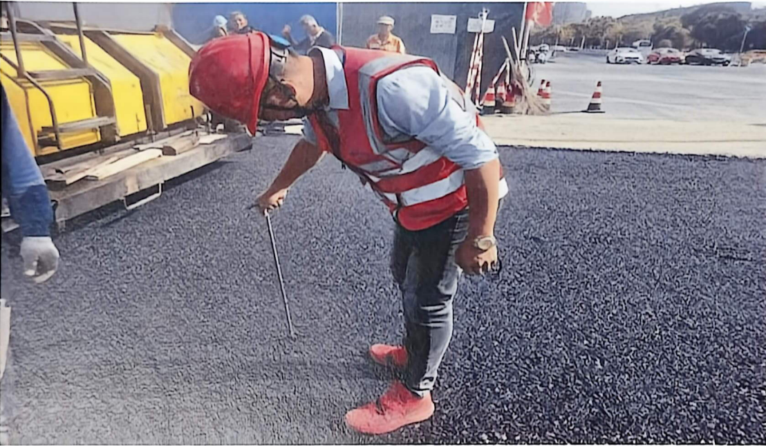
沥青混合料摊铺虚铺厚度检测
