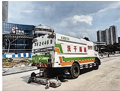
封层施工前吸尘车清扫
