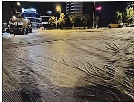
交叉口满铺经编玻纤格栅复合土工布
