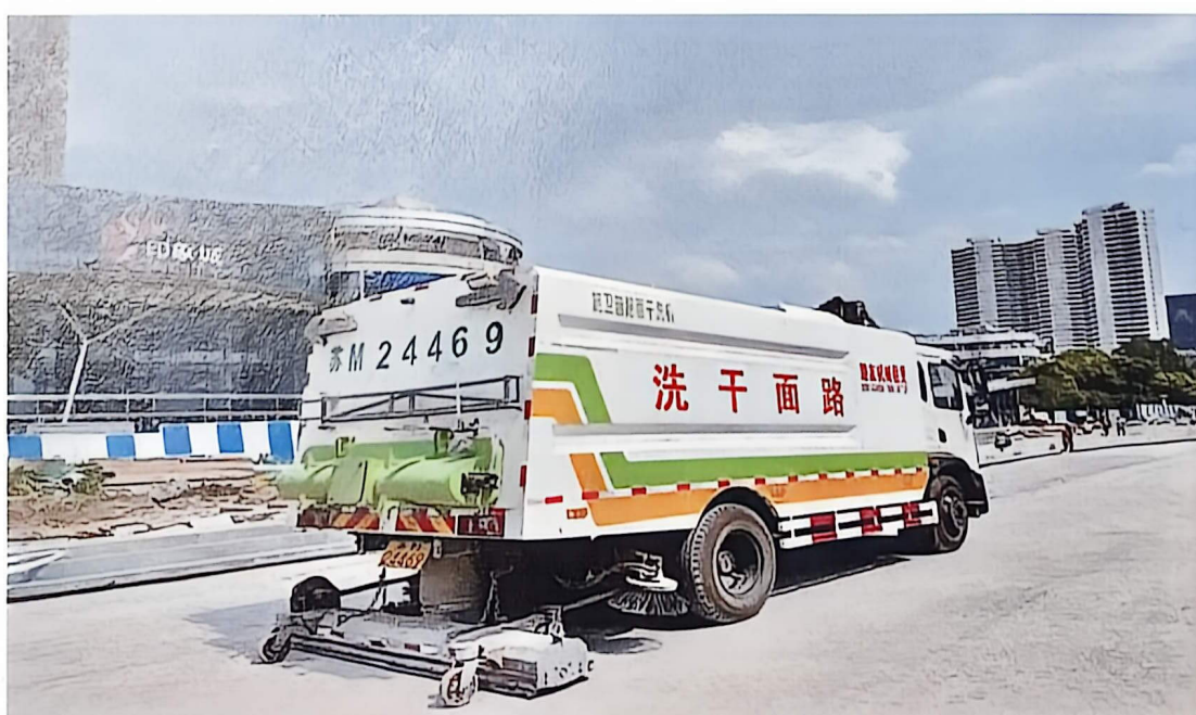
碎石纤维封层施工前清扫
