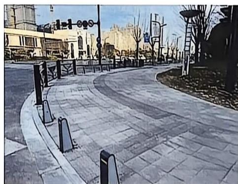
铺砌完成后的实际效果
