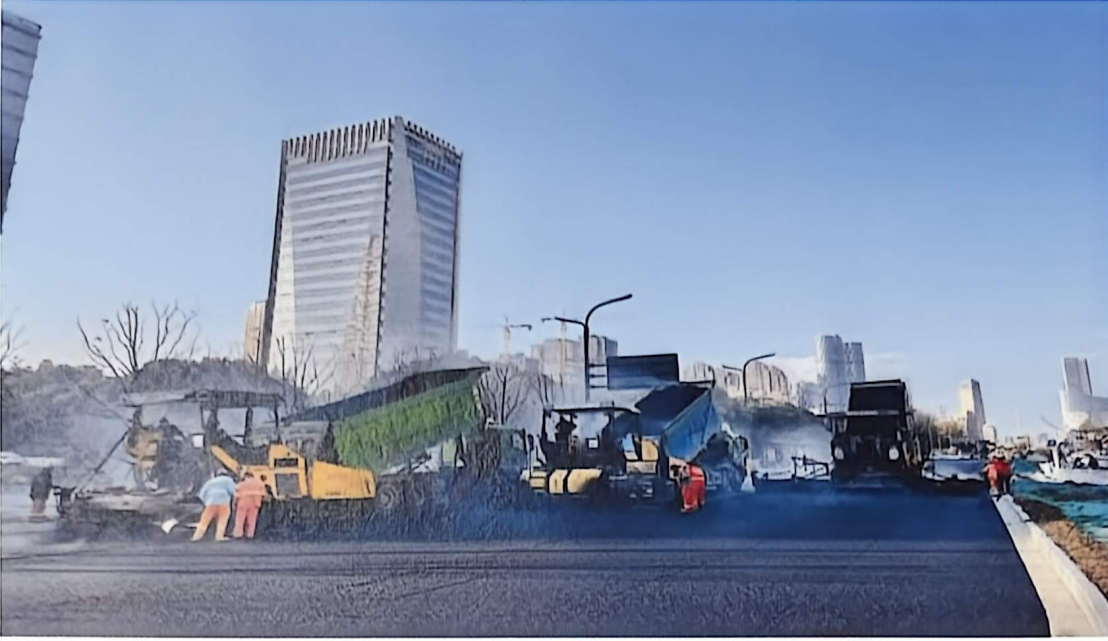
沥青混合料摊铺
