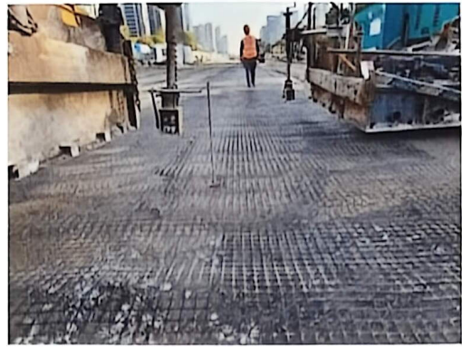
新老路基搭接上方铺贴土工格栅
