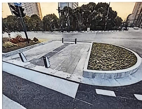
现场侧平石安装效果
