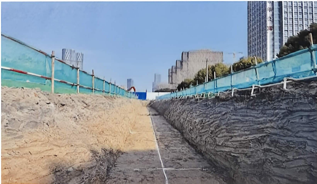
雨水管道沟槽开挖
