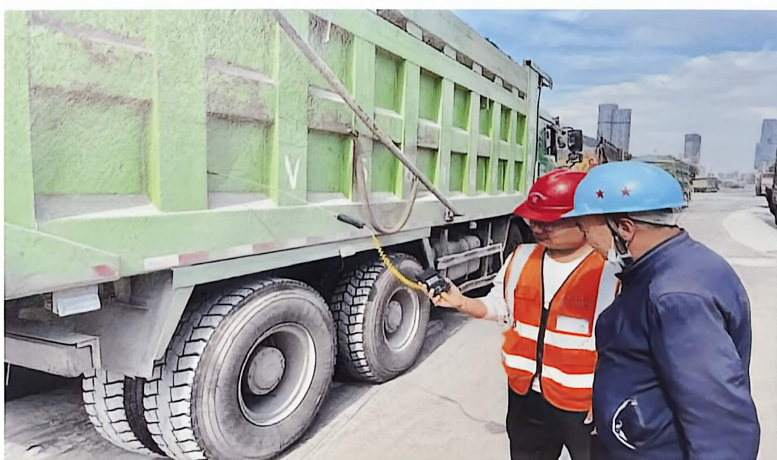
沥青混合料进场测温
