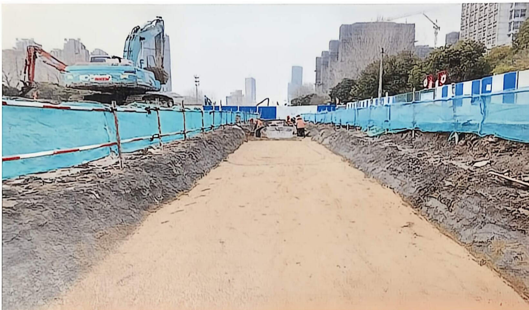
雨水管道沟槽回填
