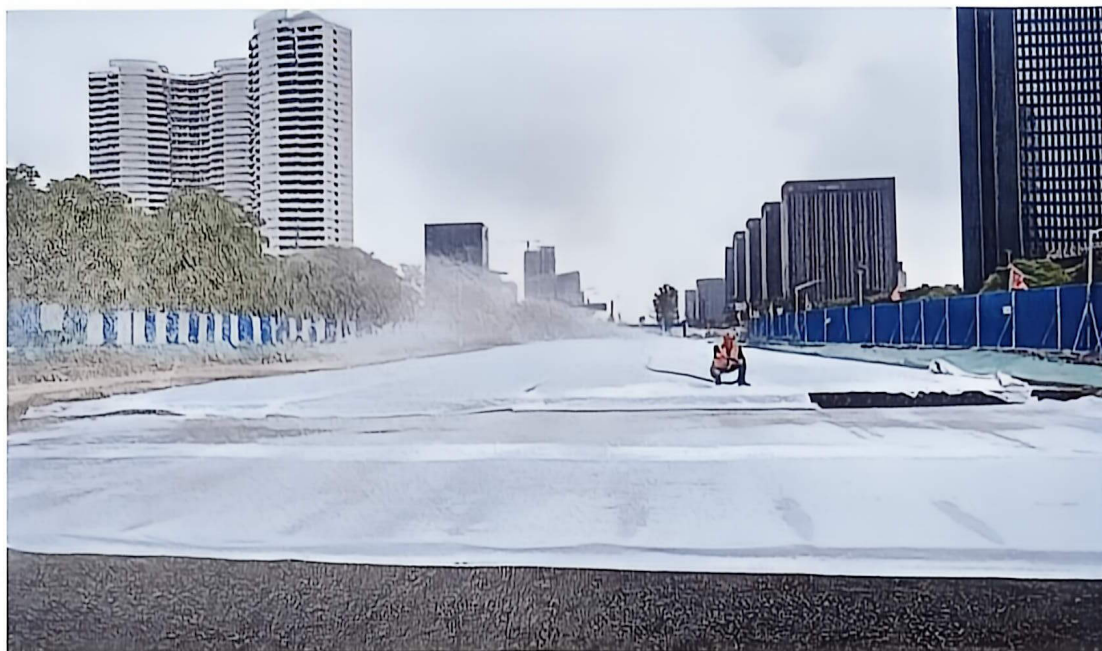
水泥稳定碎石洒水养生
