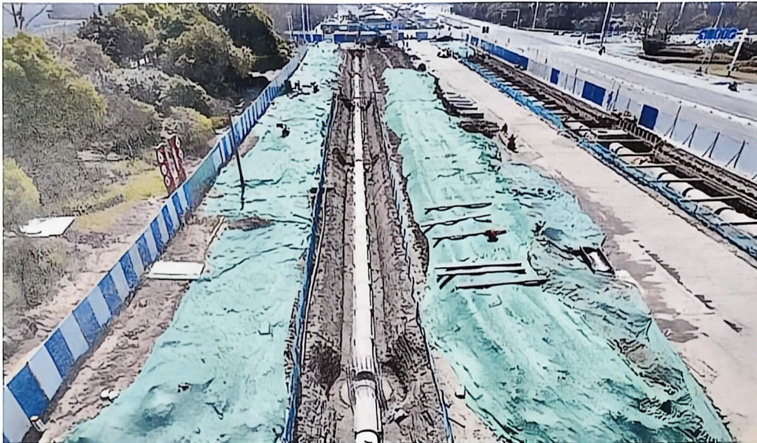
雨水管道安装完成
