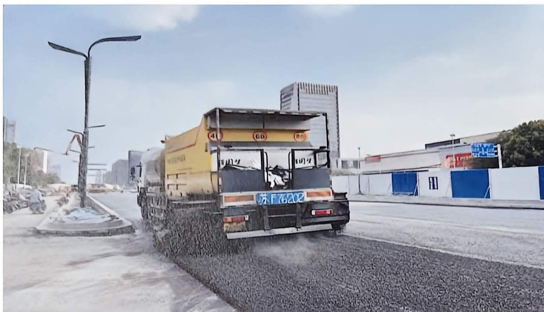
碎石纤维封层施工
