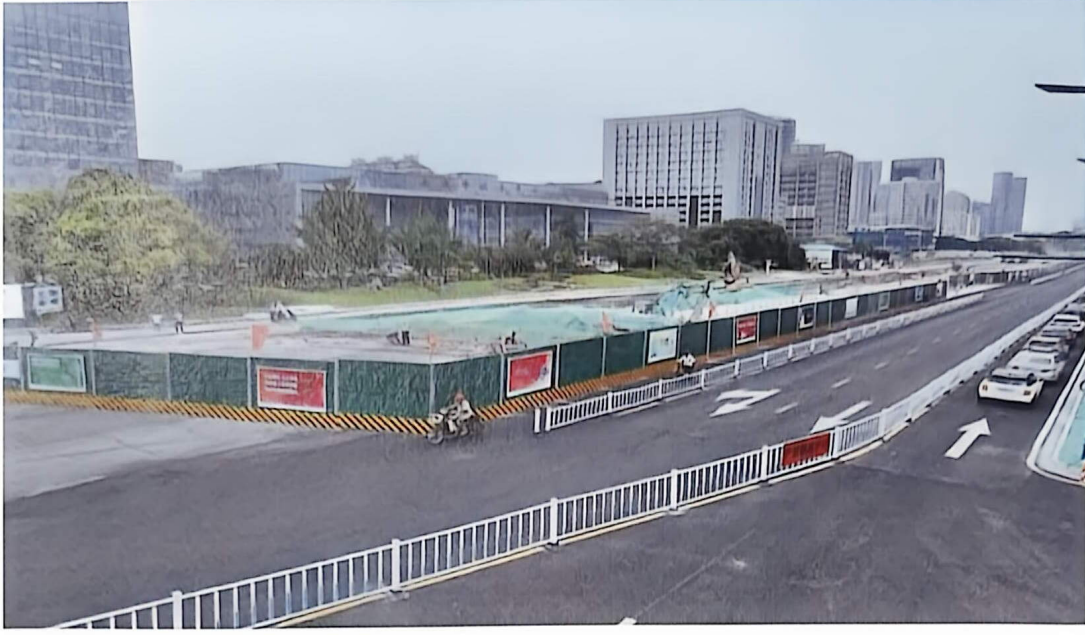
围挡全封闭施工
