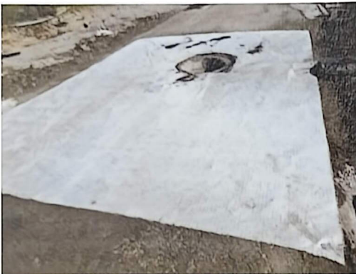
检查井周铺贴抗裂土工布
