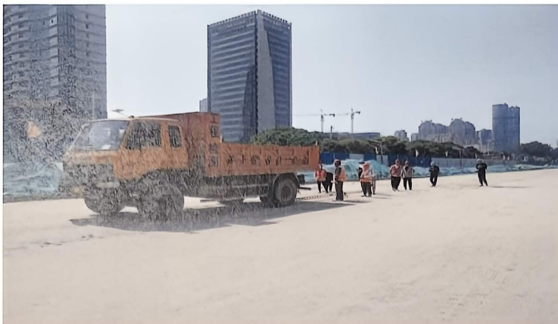
泥灰碎石弯沉检测
