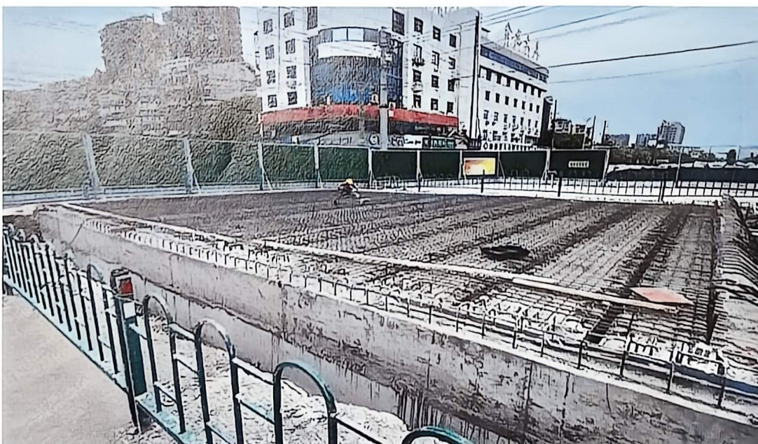
桥面铺装施工
