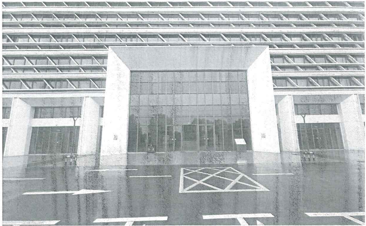
照片三：主入口实体照片
