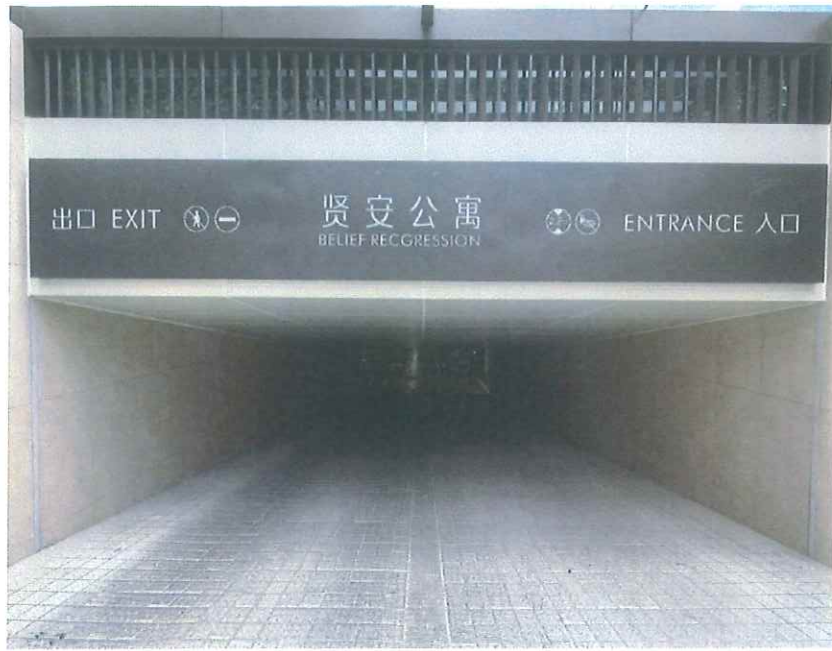
汽车坡道入口
