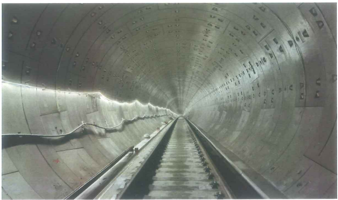
照片 8：区间普通道床轨道全貌
