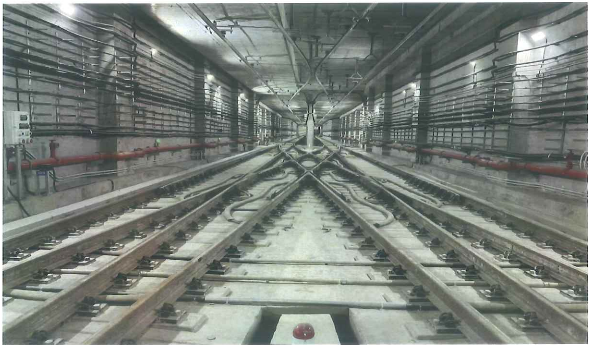
照片 9：车站交叉渡线全貌
