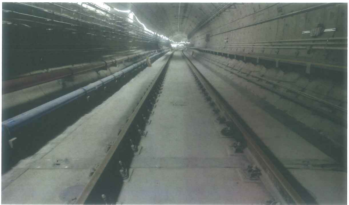
照片 10：区间钢弹簧浮置板道床轨道全貌
