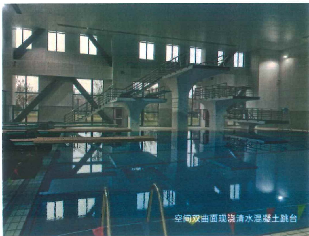
国际标准比赛泳池，吸音穿孔石膏板墙面，定制铝单板吊顶
