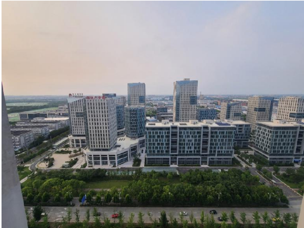
16.C11079 地块二期建设项目图片
